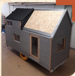
Bardage extérieur et toiture
